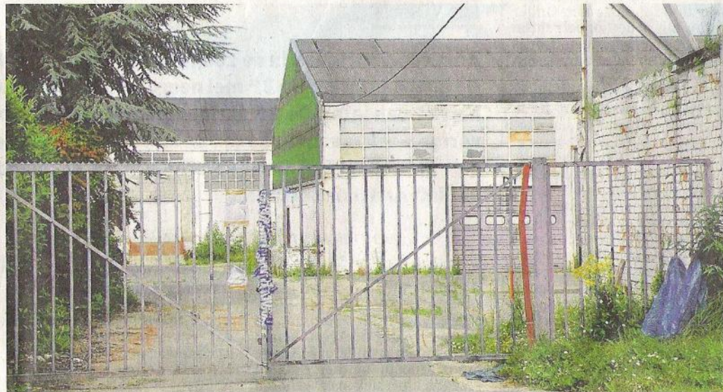
Deze gebouwen op de Valentinesite zullen worden afgebroken. Foto Galicia
